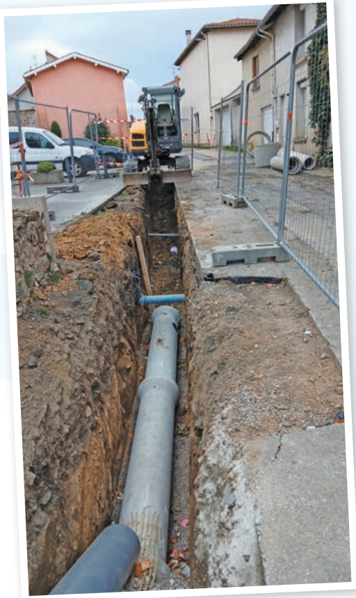
Mise en séparatif du réseau d'assainissement - route du Verjollat et chemin du Pêchy
